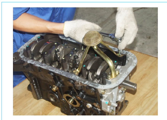
图2-98 安装集滤器
